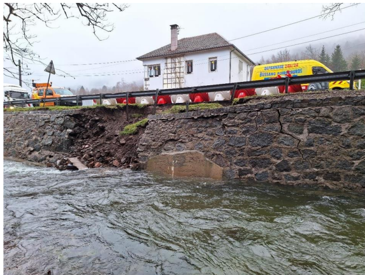
Figure 2 – Vue de l'effondrement du mur au PR33+790
